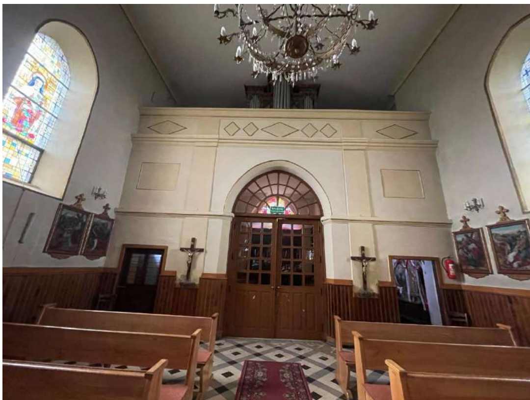
Ściana od strony chóru Stan malatury wnętrza 2023
